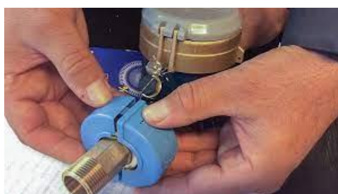
2. kép – VIPAK zár felhelyezése
